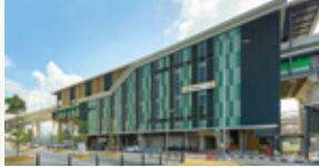
Kuchai MRT Interchange Station MRT 2 & MRT 3 (Future)
