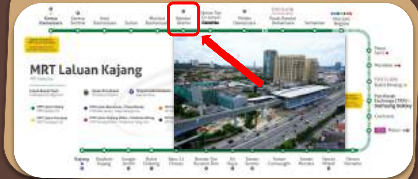
BANDAR UTAMA MRT STATION
